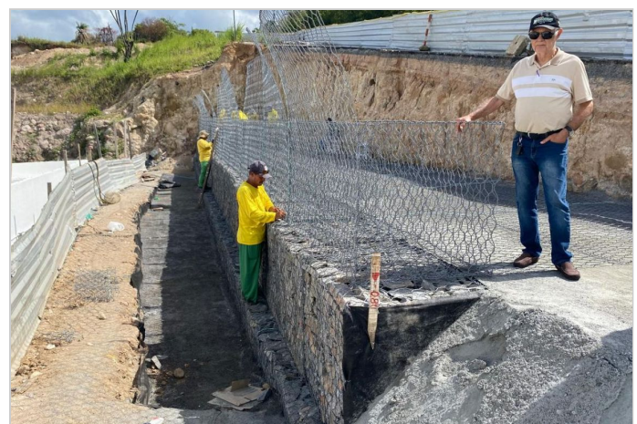
Durante a obra
