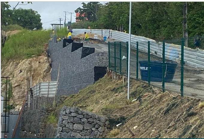
Durante a obra
