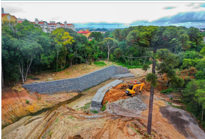
Durante a obra
