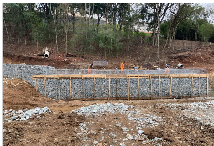
Durante a obra
