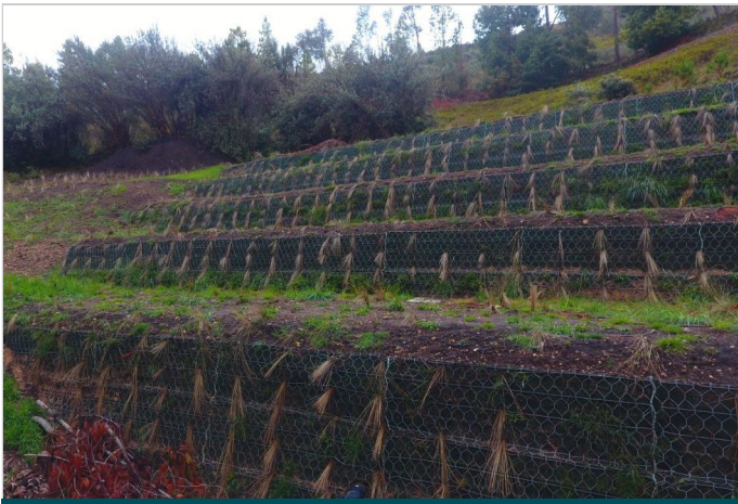
Durante la Obra
