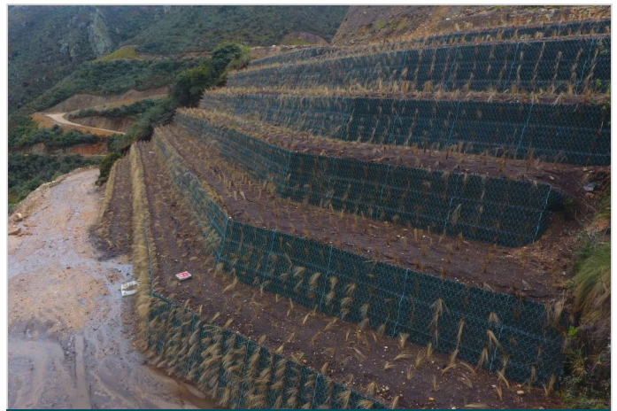
Durante la Obra
