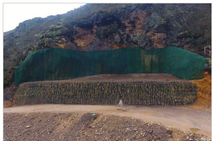
Durante la Obra
