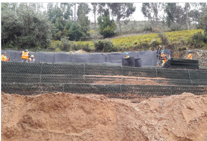
Durante la Obra
