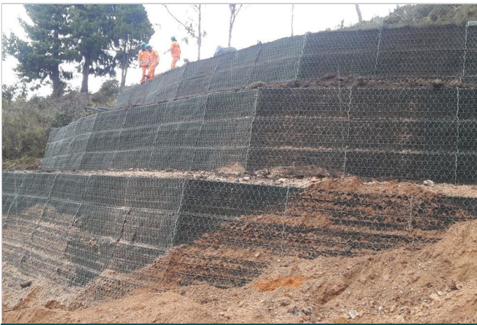
Durante la Obra
