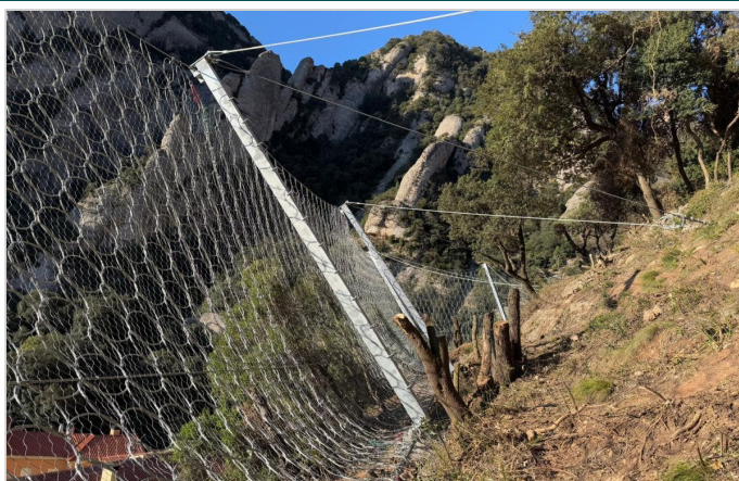
Instalación completada de la barrera RB3000
