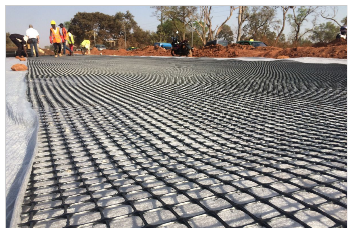
Mise en oeuvre MacGrid EG
