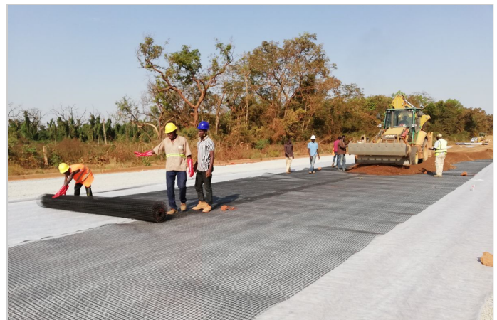
Mise en oeuvre MacGrid EG
