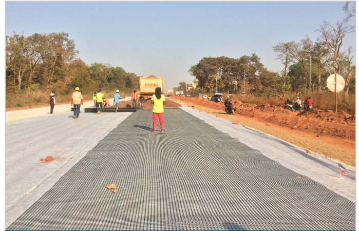
Mise en oeuvre MacGrid EG
