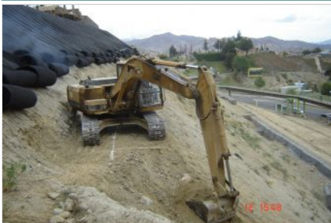
Durante a obra
