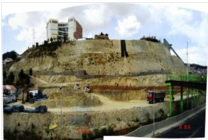
Durante a obra
