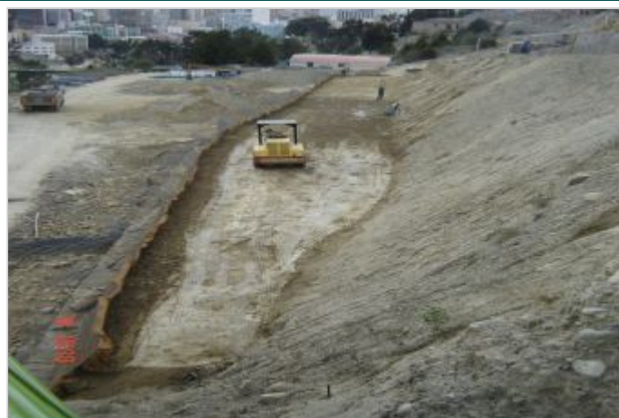
Durante a obra
