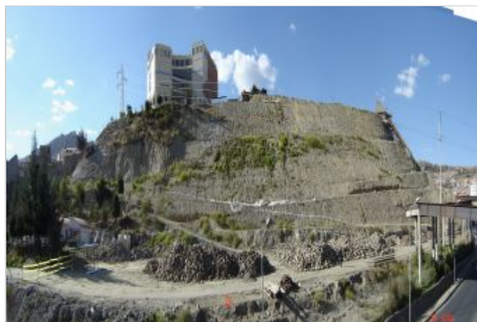
Antes da Obra
