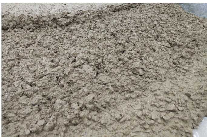
钢纤维混凝土浇筑
