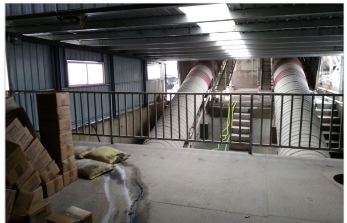
钢纤维添加进入混凝土
