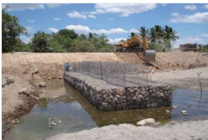
Durante a obra
