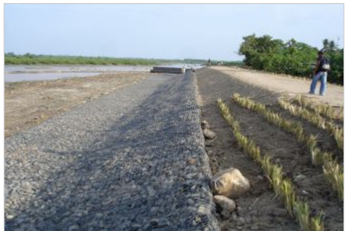
Durante a obra
