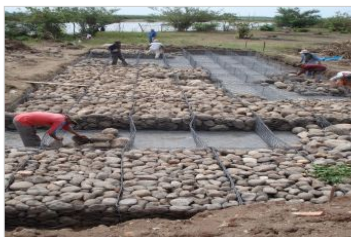
Durante a obra
