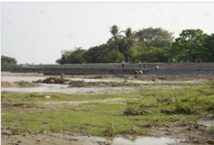
Durante a obra
