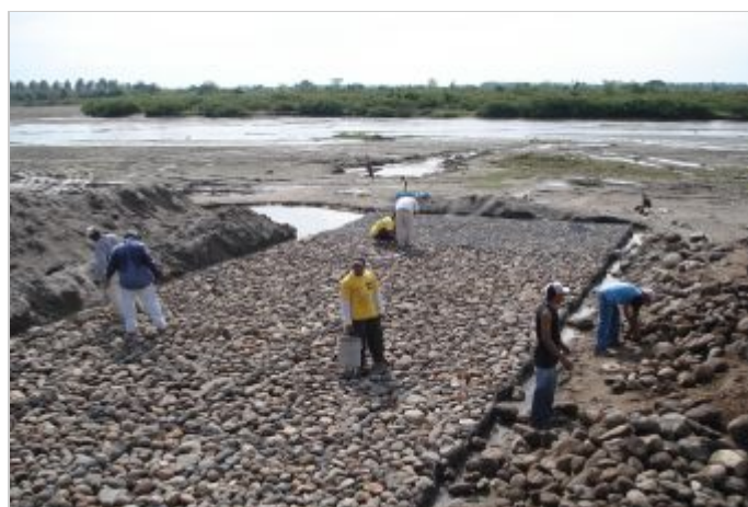
Durante a obra
