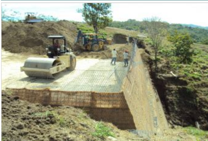
Durante a obra
