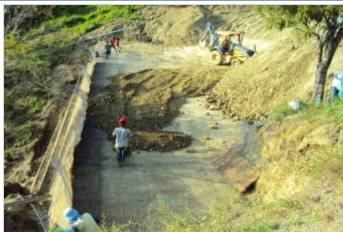
Durante a obra
