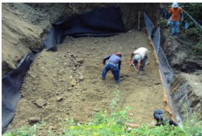
Durante a obra
