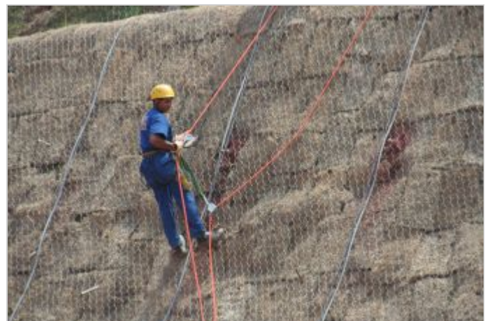
Durante la Obra
