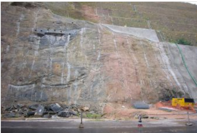
Durante la Obra
