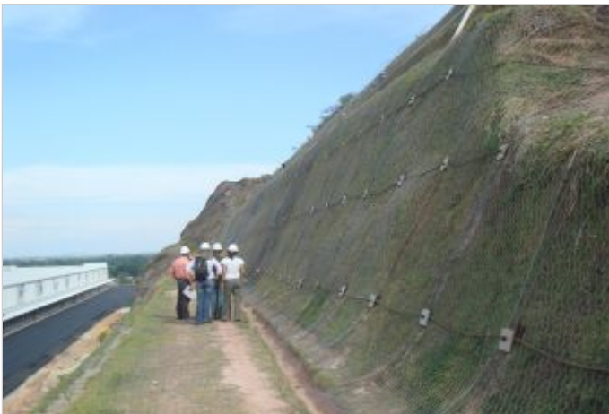
Durante la Obra
