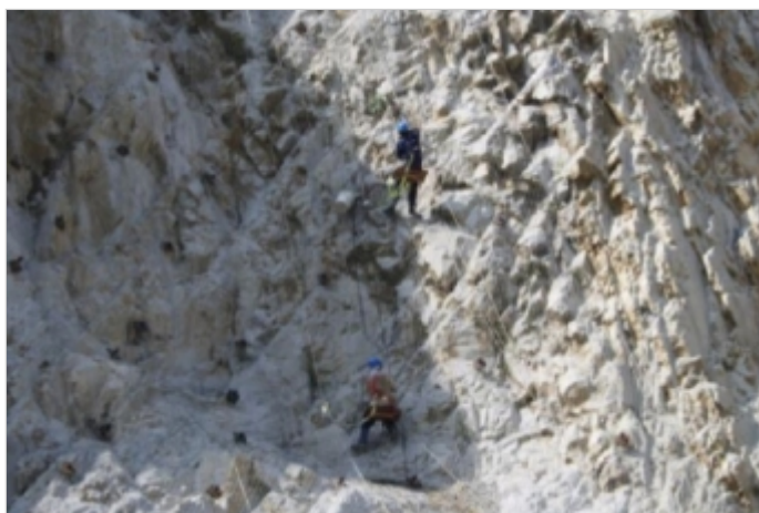
Durante a obra
