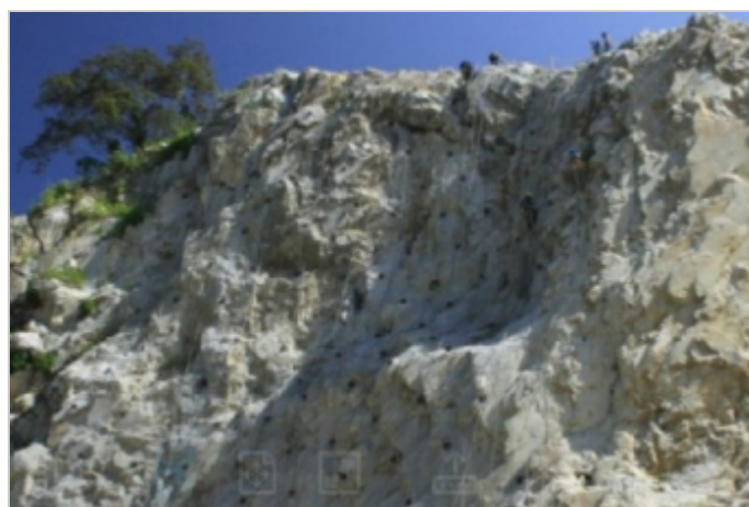
Durante a obra
