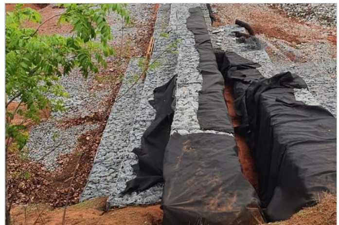
Durante a obra
