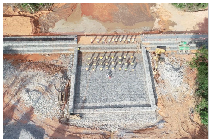
Durante a obra
