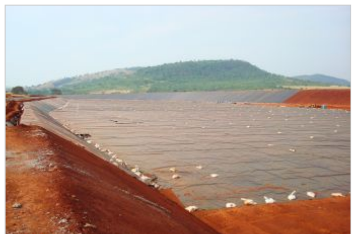
Durante la Obra
