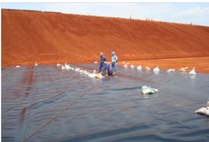
Durante la Obra
