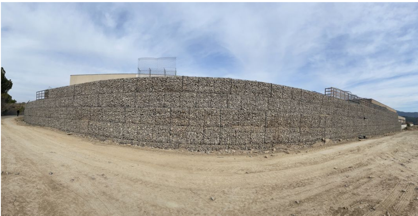
Vista panorámica del muro Terramesh System®
