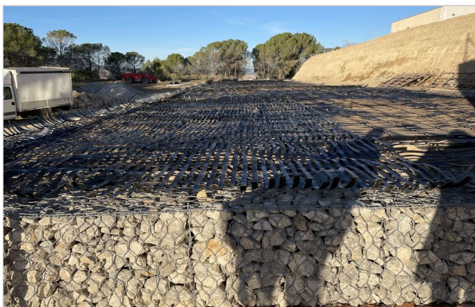
Detalle geomallas en cierre lateral del muro
