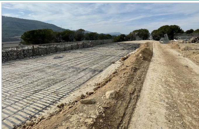
Extendido de las geomallas ParaGrid®
