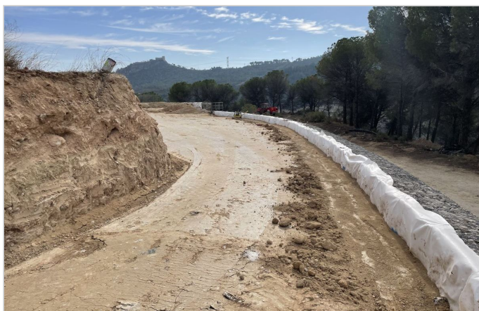
Muro Terramesh durante la instalación
