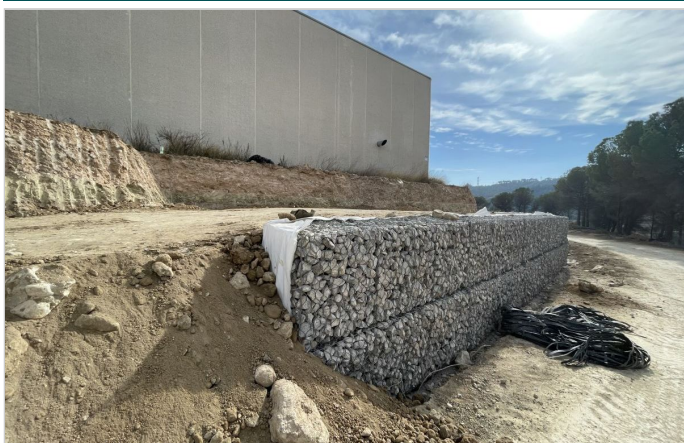
Final del muro (altura 2 m)
