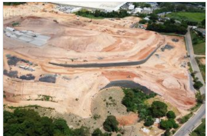
Durante la Obra
