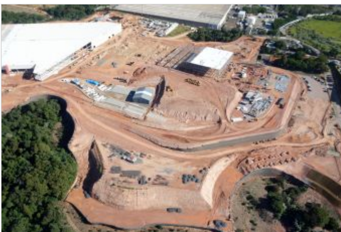
Durante la Obra
