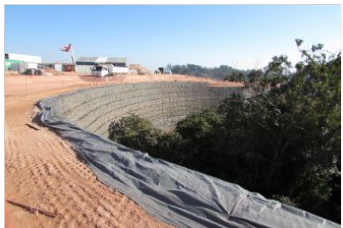
Durante la Obra
