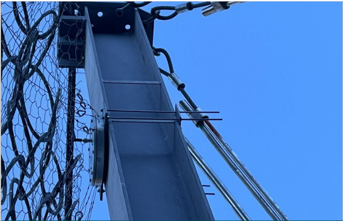
Vista lateral de la instalación del Hellomac en el poste de la barrera RB 9000
