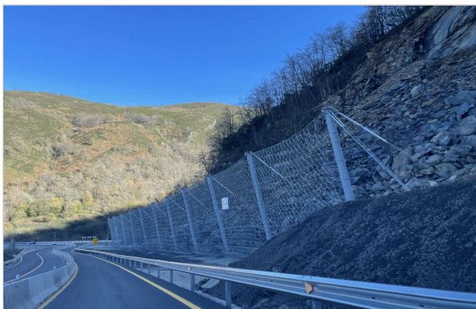
Instalación de barrera RB9000 vista desde la vía
