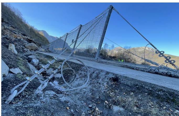
Barrera RB9000 vista desde el talud
