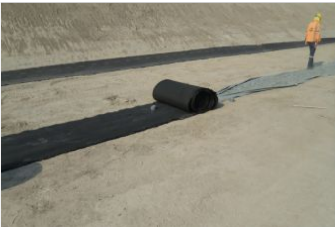
Durante a obra
