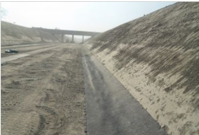
Durante a obra
