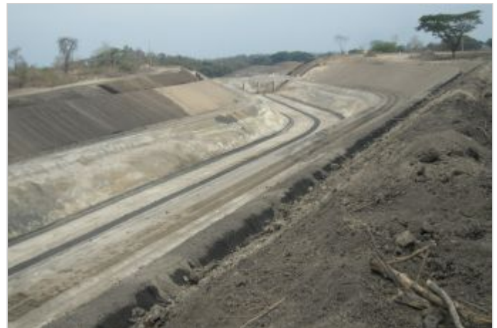
Durante a obra
