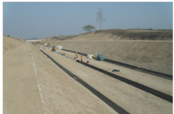
Durante a obra
