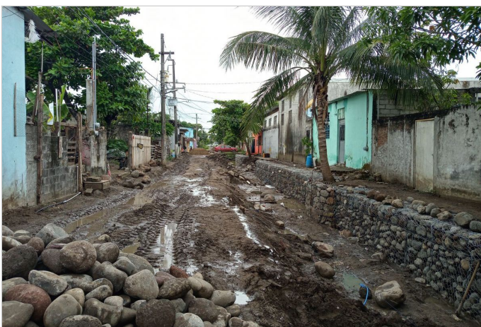
Durante la Obra
