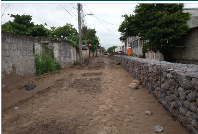
Durante la Obra
