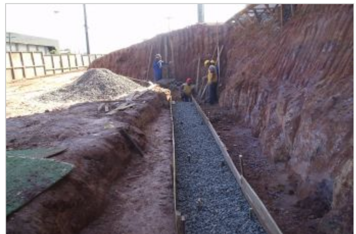
Durante a obra
