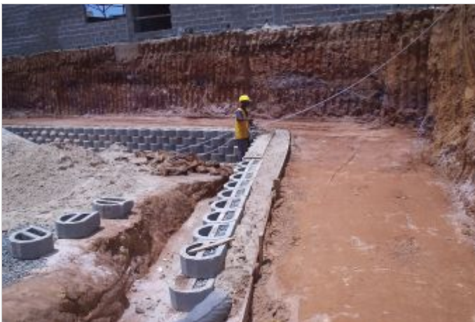
Durante a obra
