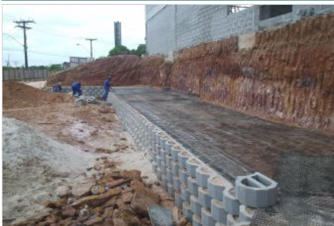
Durante a obra
