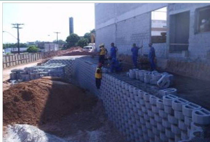
Durante a obra
