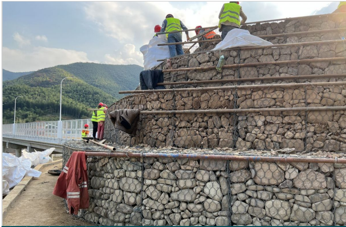
侧边坡高强格宾施工
