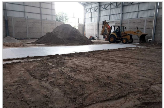
Durante la Obra
