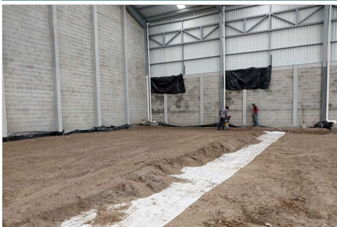
Durante la Obra
