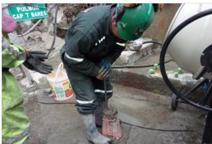
Durante la Obra
