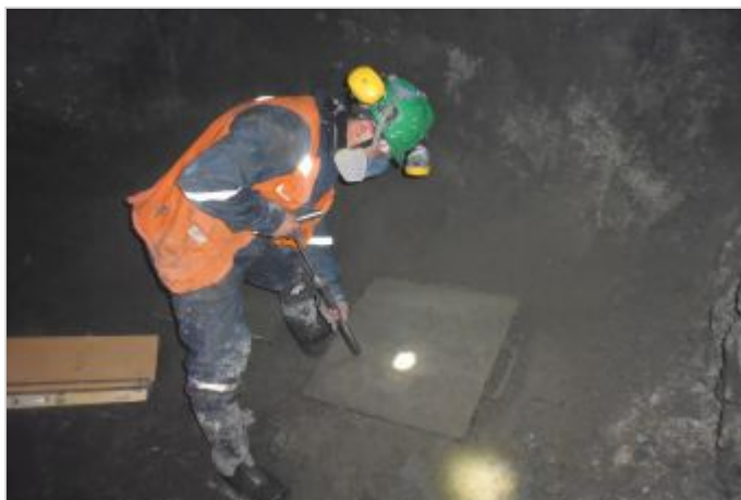
Durante la Obra
