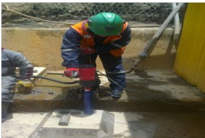
Durante la Obra
