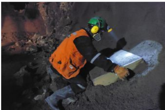
Durante la Obra
