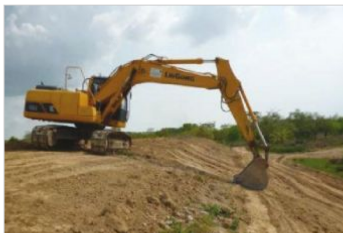
Durante a obra
