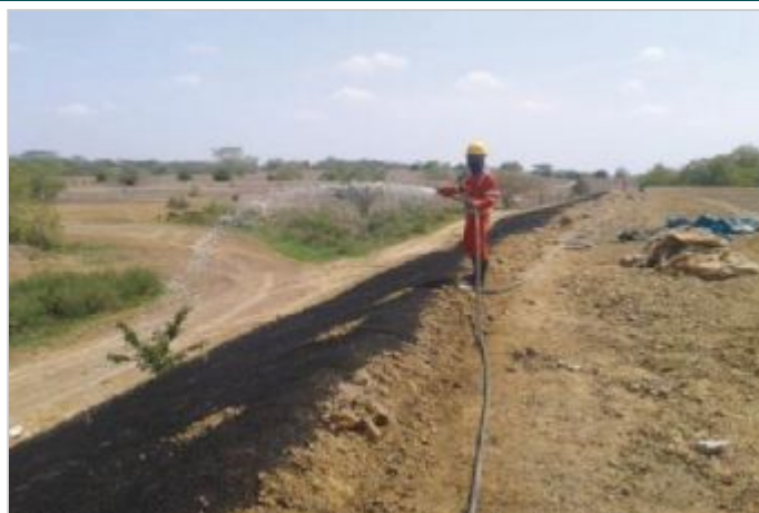
Durante a obra
