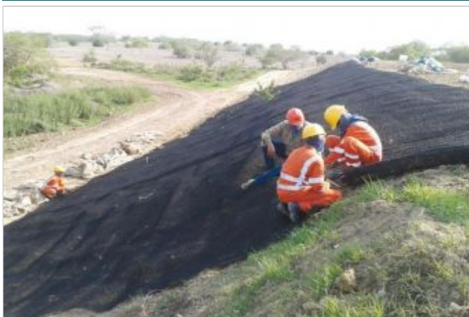
Durante a obra
