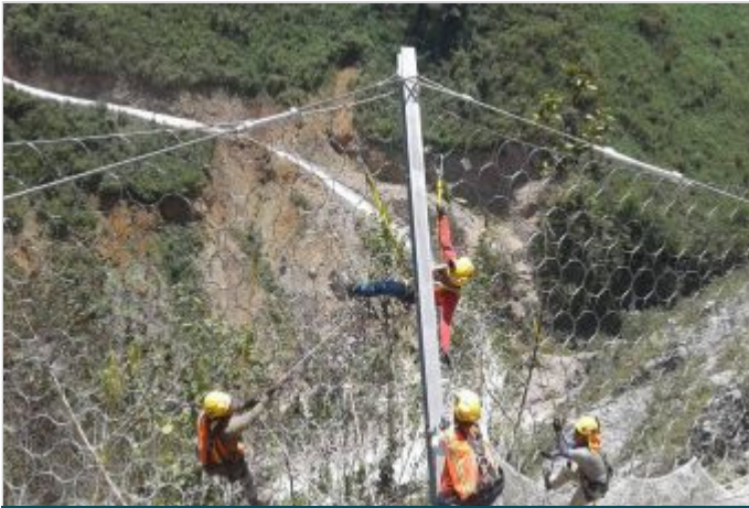
Durante a obra
