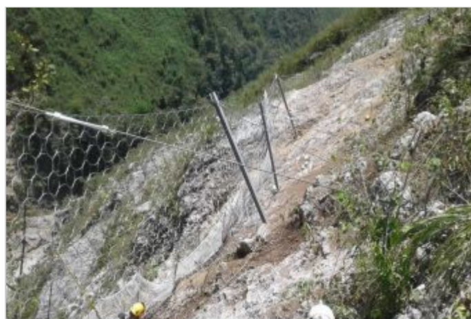
Durante a obra
