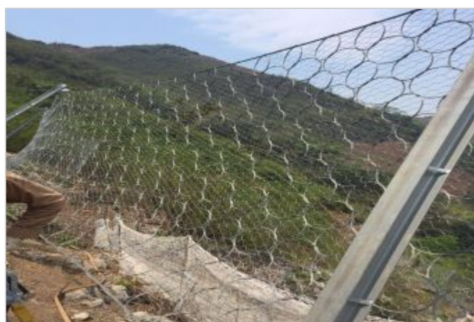
Durante a obra
