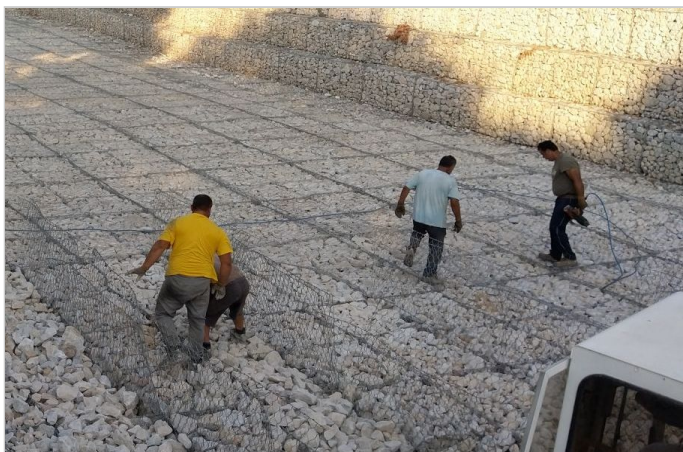
Συρραφή συρματοκιβωτίων με ειδικά δακτυλίδια συρραφής
