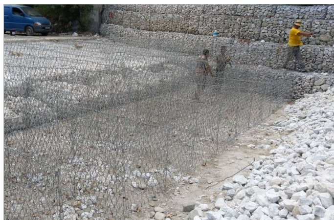
Τοποθέτηση συρματοκιβωτίων
