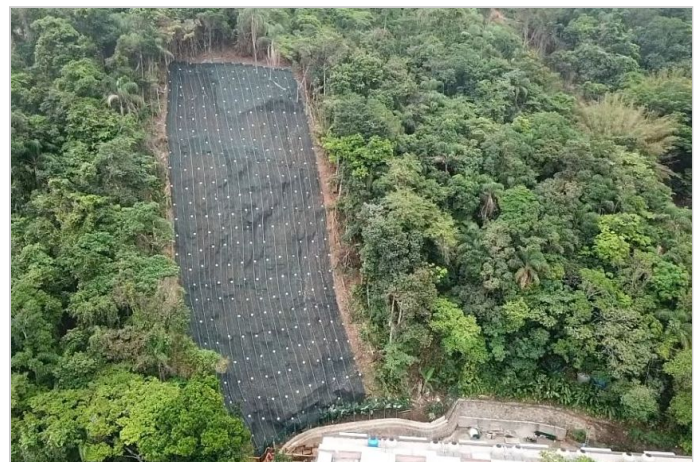
Durante a obra
