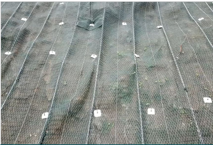
Durante a obra
