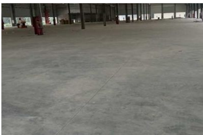
图5 钢纤维混凝土地面成品
