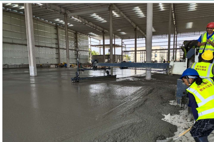
图4 钢纤维混凝土整平
