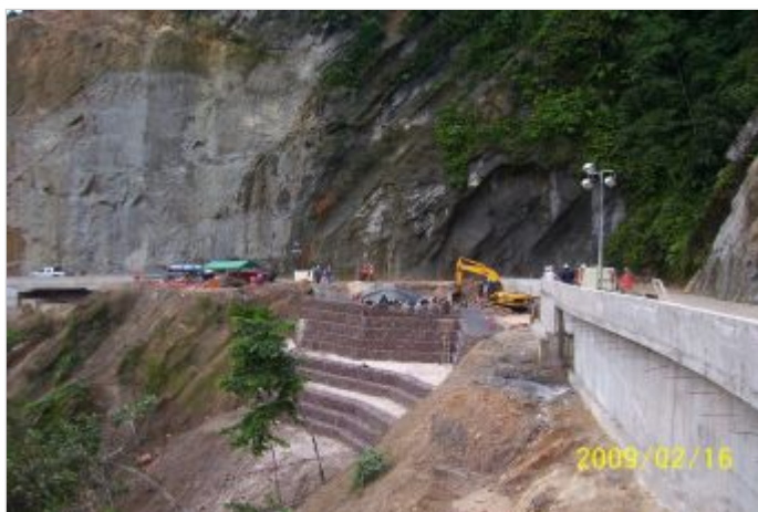
Durante a obra
