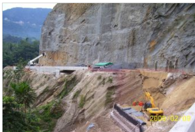
Durante a obra
