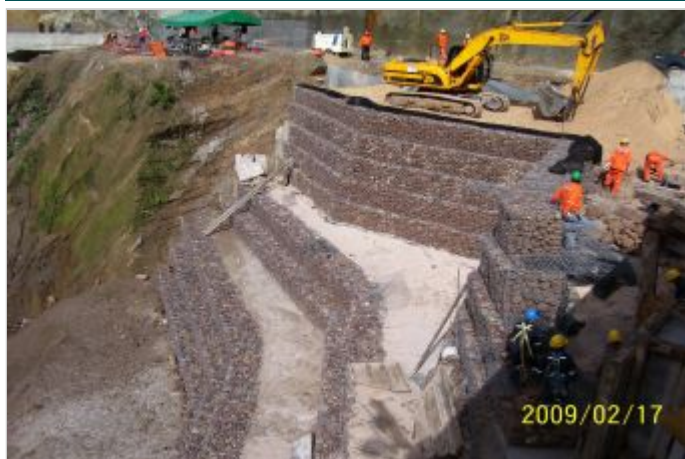
Durante a obra
