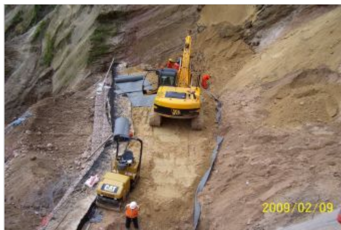
Durante a obra
