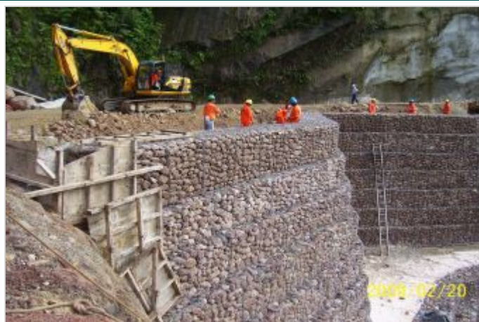
Durante a obra
