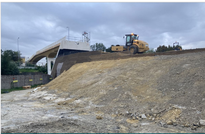
Ouvrage en cours - Rampe nord
