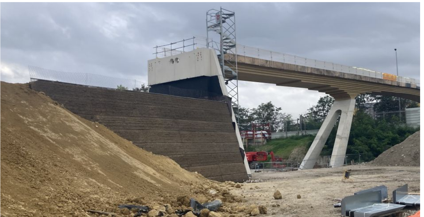
Ouvrage en cours de réalisation - Rampe nord
