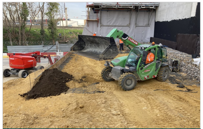
TerraMesh Vert et TerraMesh System - Rampe sud
