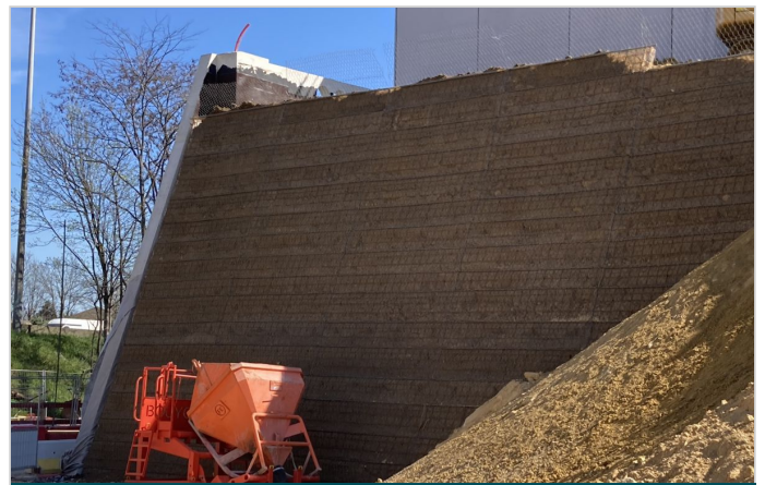
Ouvrage en cours - Rampe sud
