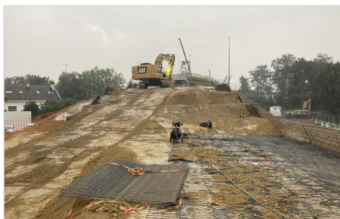
Pose du TerraMesh Vert et de la ParaGrid - Rampe nord
