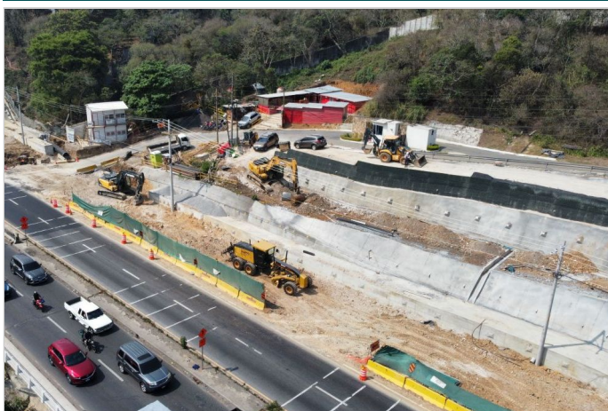
Durante la Obra
