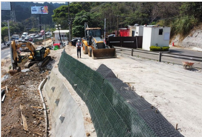
Durante la Obra
