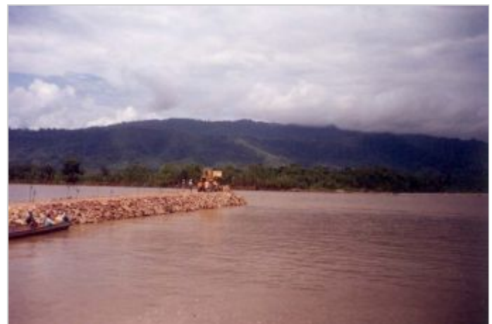
Durante la Obra
