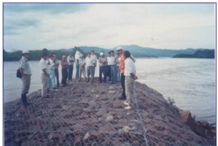
Durante la Obra
