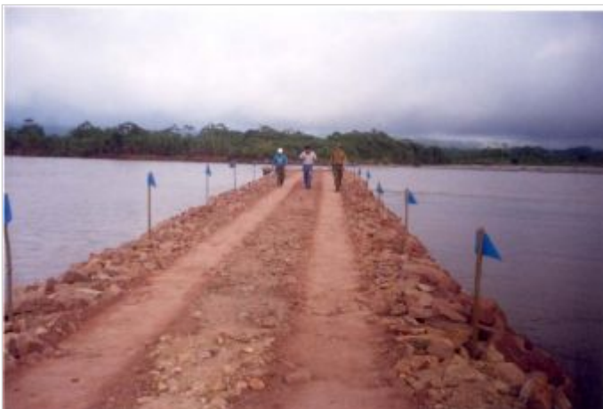
Durante la Obra
