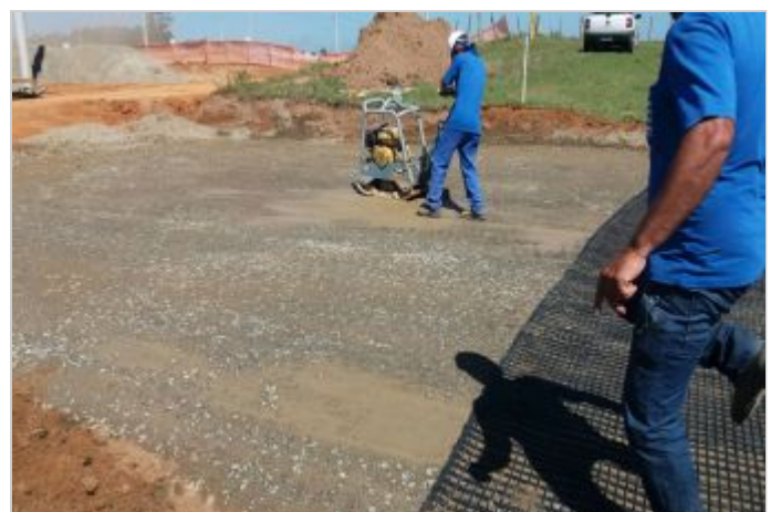
Durante la Obra
