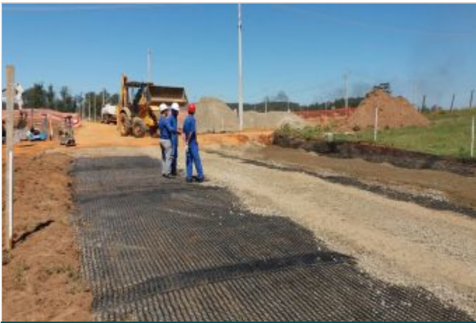
Durante la Obra
