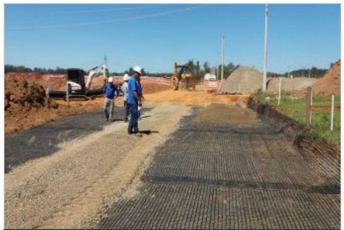
Durante la Obra
