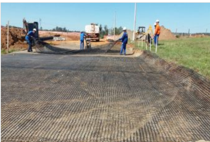
Durante la Obra
