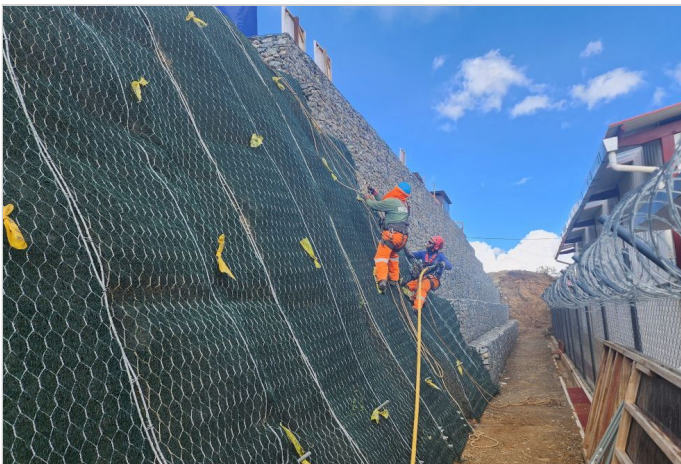
Durante la Obra
