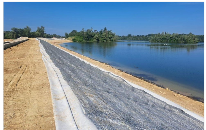
Vue d'ensemble des matelas Reno en cours de remplissage
