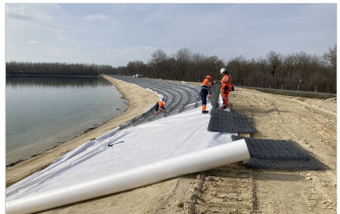
Matelas Reno en cours d'installation
