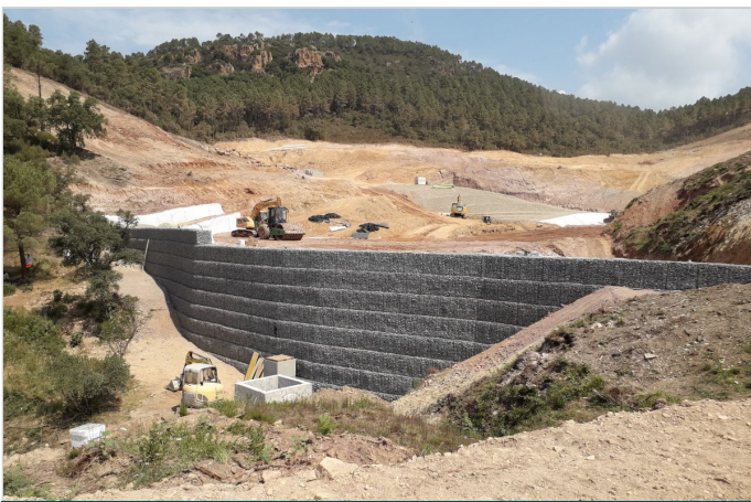
Digue des bassins ERE+ERI - Pendant les travaux
