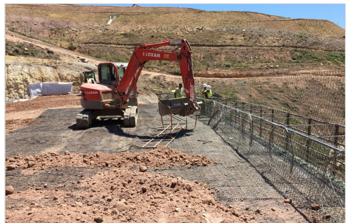
Digue des bassins ERE+ERI - Pendant les travaux
