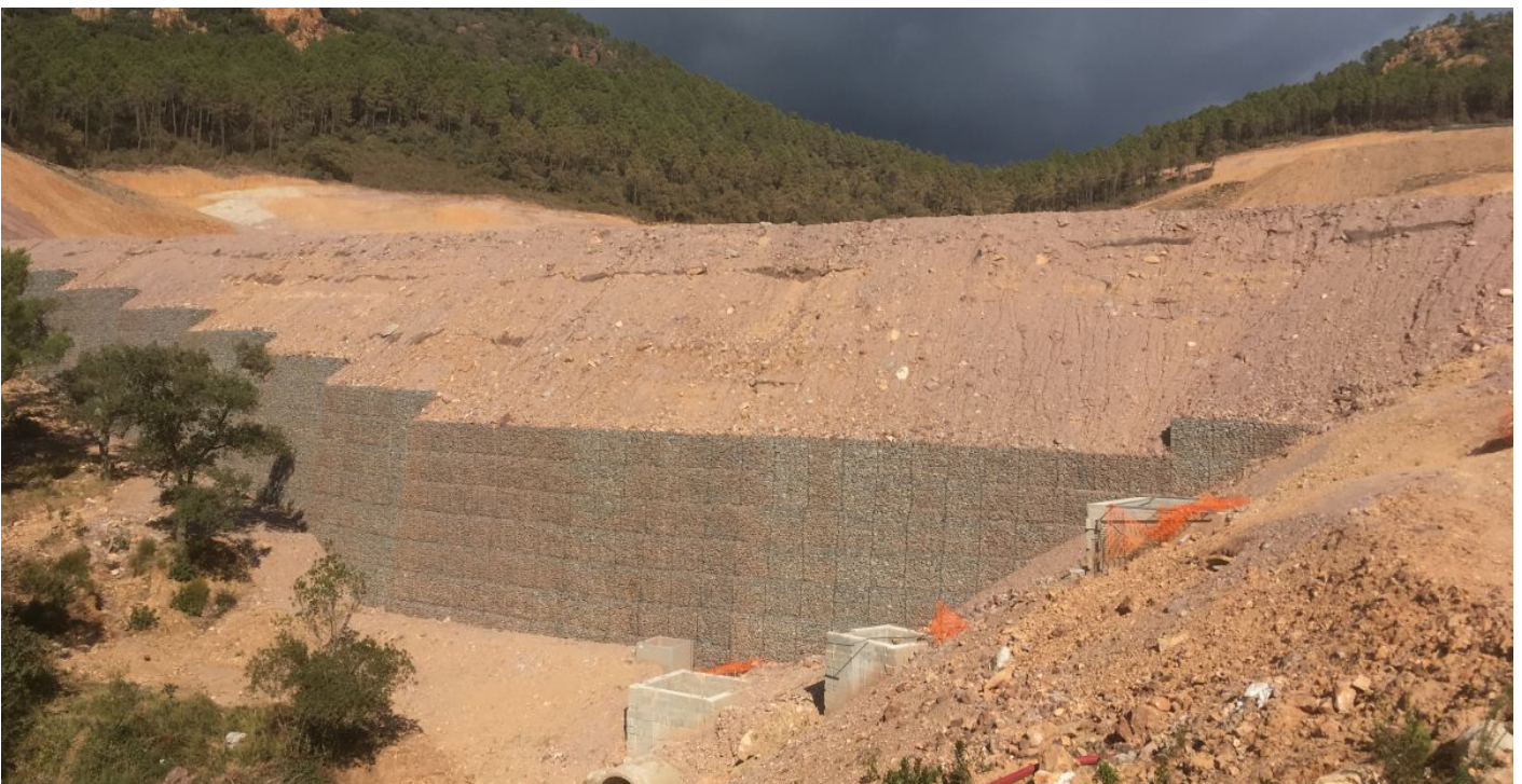
Digue des bassins ERE+ERI - Après les travaux
