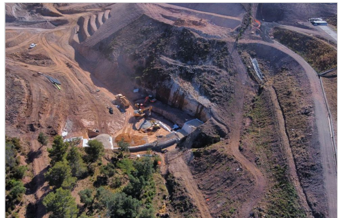
Digue des bassins ERE+ERI - Mise en oeuvre Mur en Terramesh System
