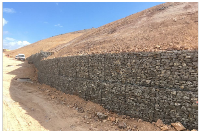
Digue du bassin des lixiviats - Pendant les travaux
