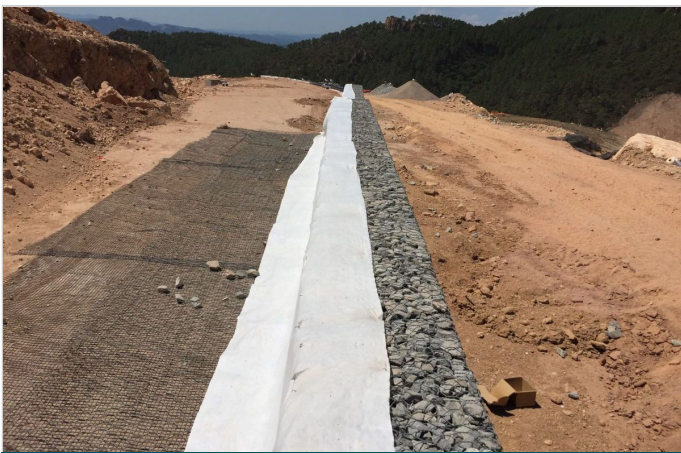
Digue du bassin des lixiviats - Pendant les travaux
