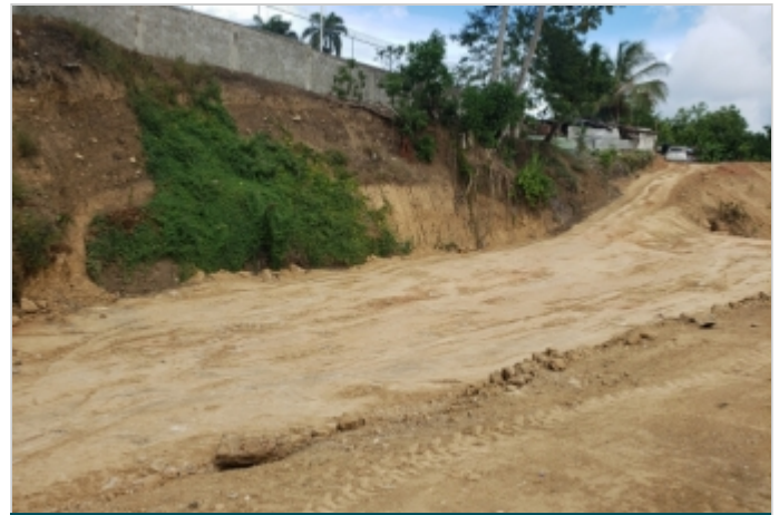
Durante la Obra
