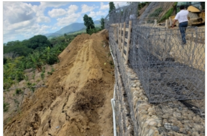
Durante la Obra
