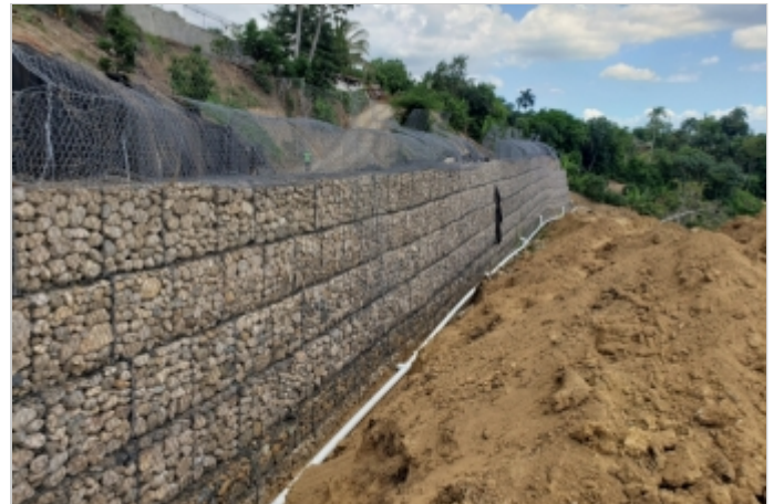
Durante la Obra
