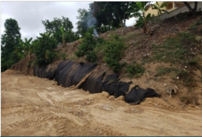
Durante la Obra
