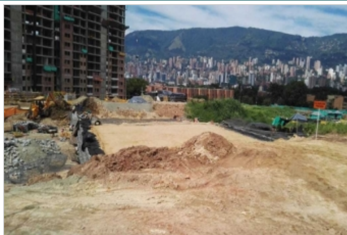
Durante a obra
