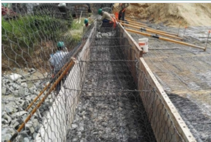
Durante a obra
