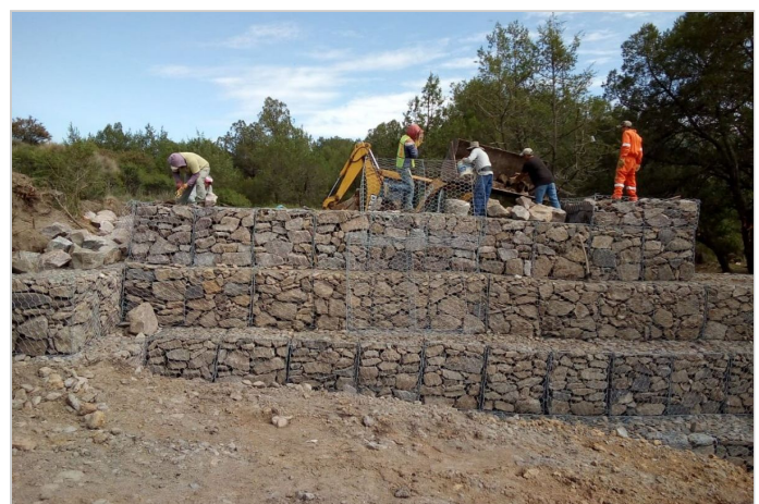
Durante la Obra
