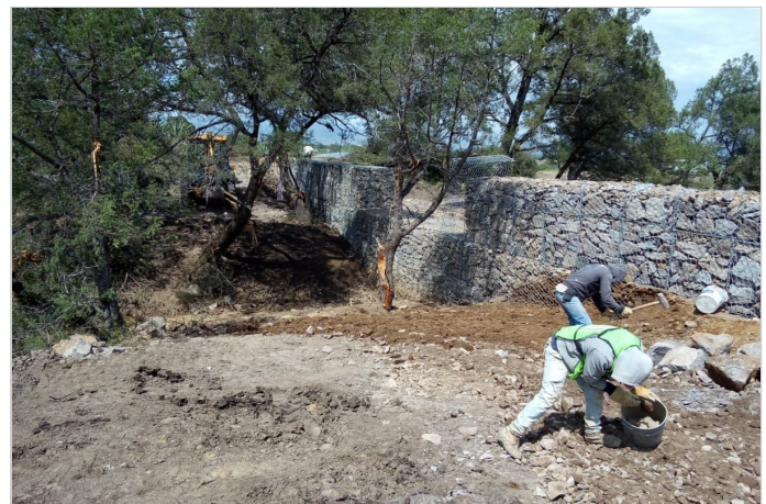
Durante la Obra
