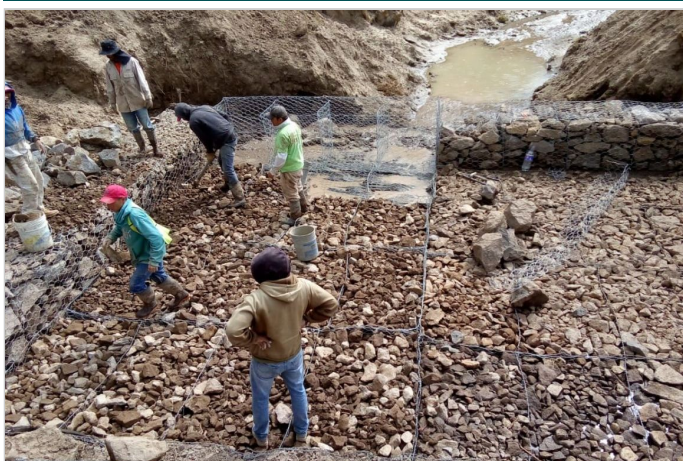
Durante la Obra
