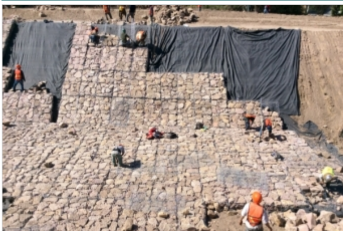
Durante la Obra
