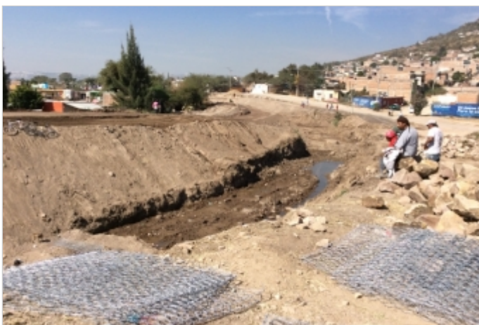
Durante la Obra
