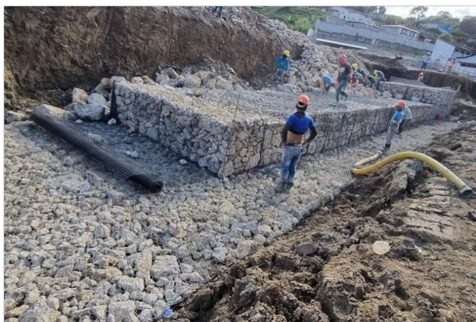
Durante la Obra
