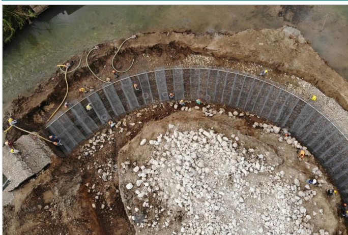
Durante la Obra
