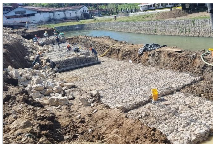
Durante la Obra
