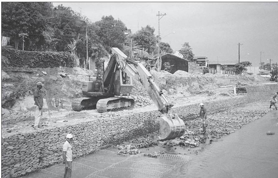
Figura 2.4.7 - Construcción de plataformas de deformación en colchones Reno®
