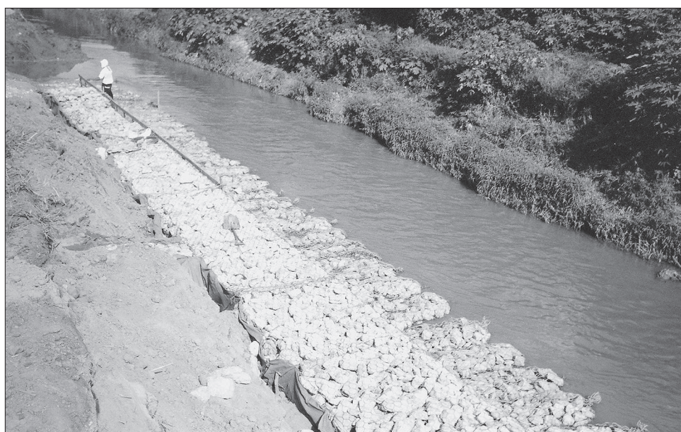
Figura 2.4.5 - Uso de gaviones tipo saco con obra en presencia de agua
