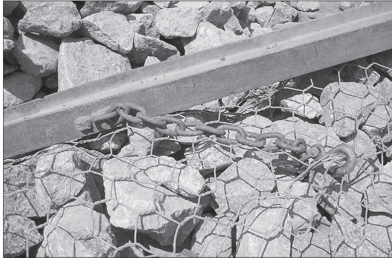
4.2.18 - Detalle del sistema de izado normalmente utilizado para la instalación de los gaviones saco
