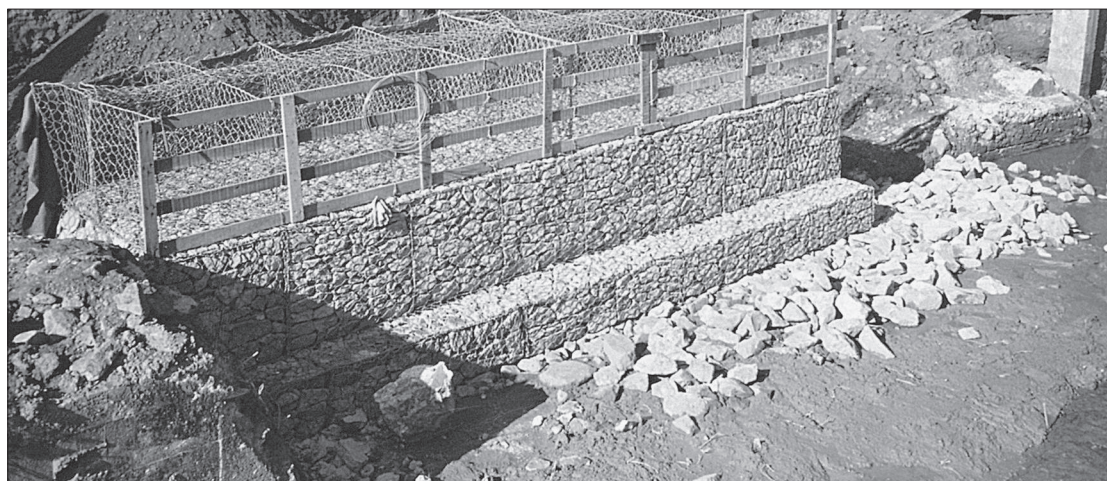
Figura 2.4.2 - Detalle constructivo de obra con gaviones caja
