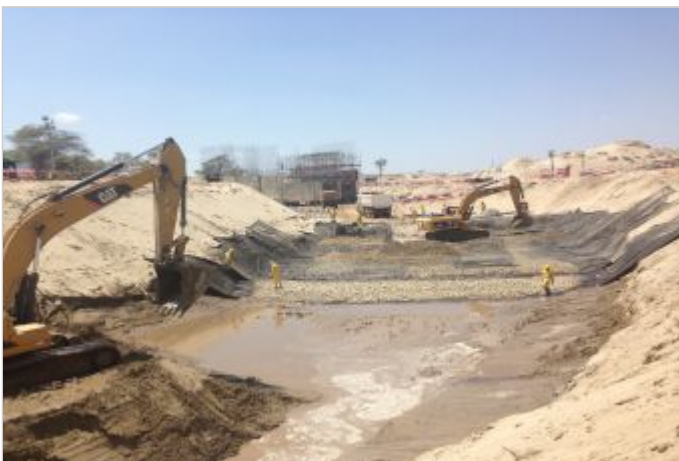
Durante la Obra
