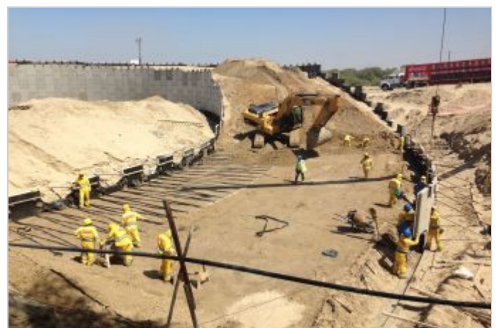
Durante la Obra
