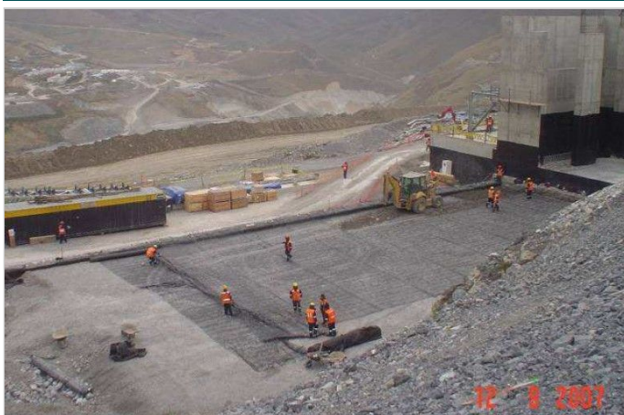
Durante la obra
