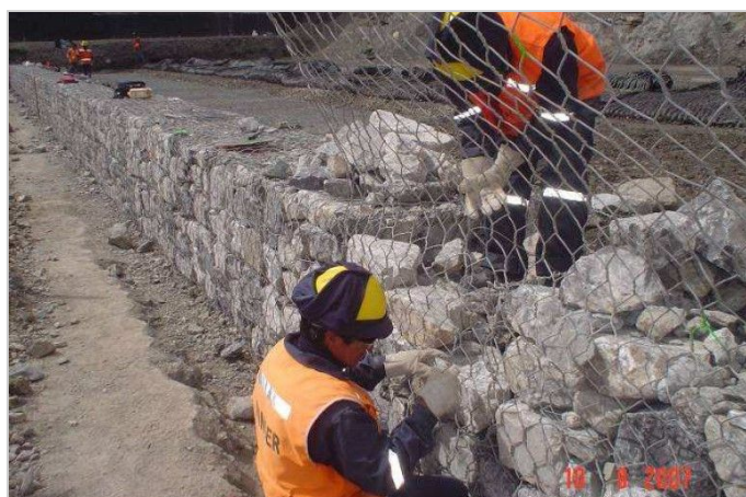
Durante la obra
