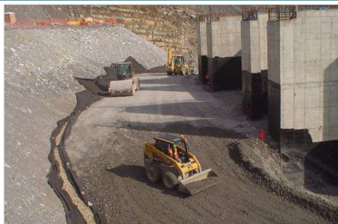
Durante la obra
