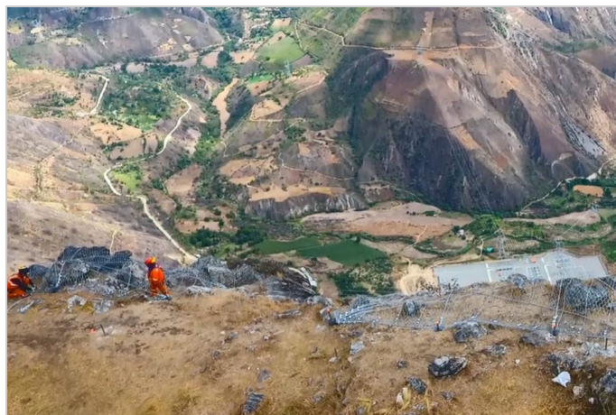
Durante la Obra
