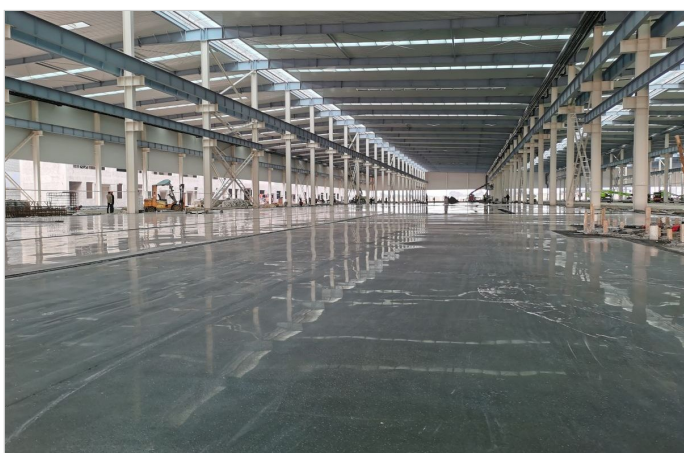
图5 固化剂施工完成后地坪效果
