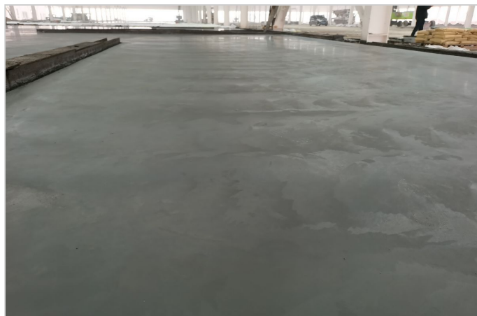
图4 钢纤维混凝土地坪施工完成后效果
