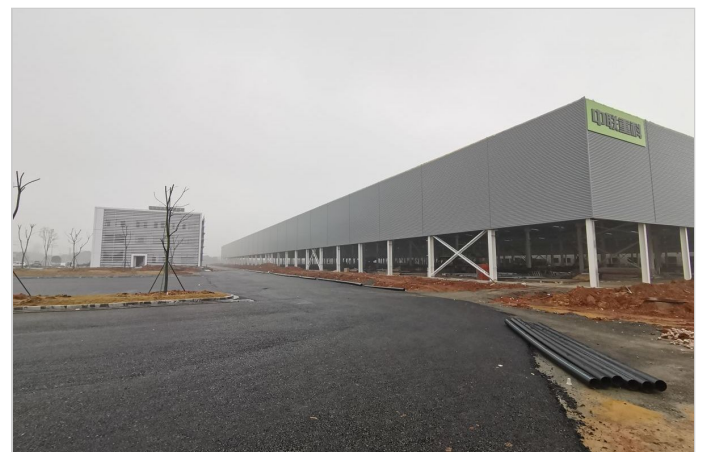
图1 项目厂房外观展示
