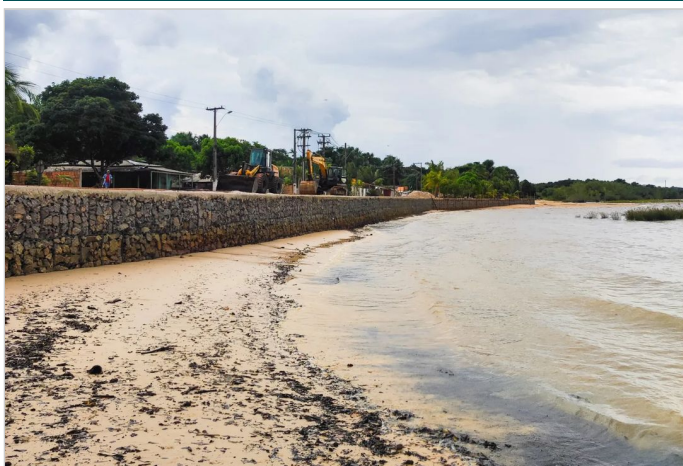
Durante a obra
