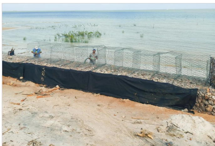
Durante a obra
