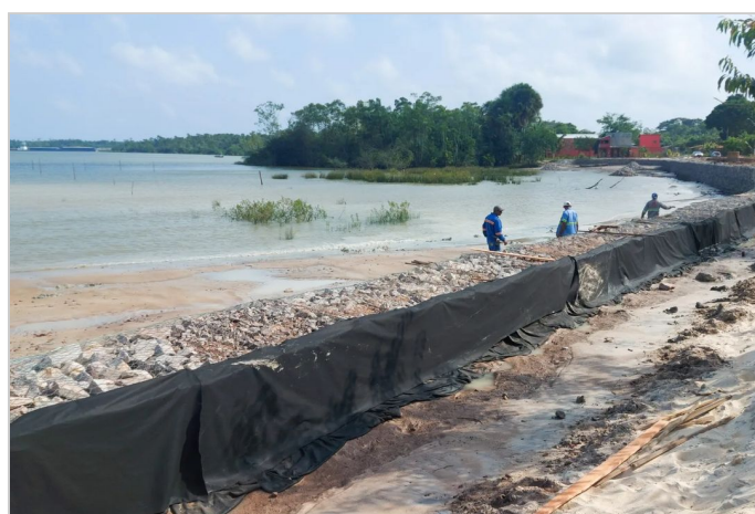
Durante a obra
