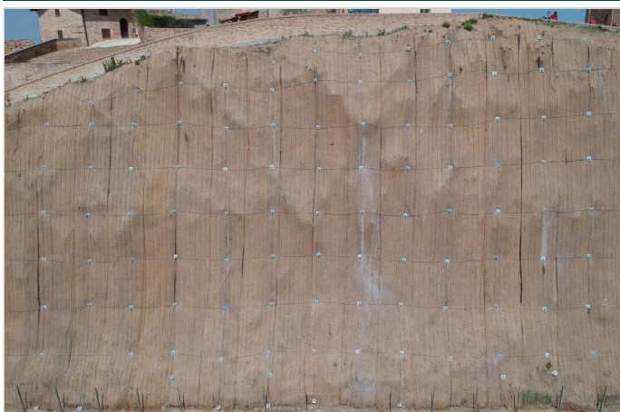
Vista di dettaglio dell'intervento di consolidamento realizzato
