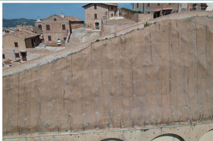
Vista di dettaglio dell'intervento di consolidamento realizzato
