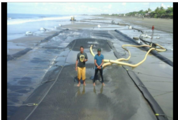
Durante a obra
