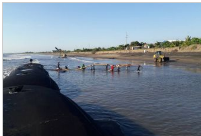
Durante a obra
