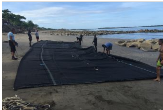
Durante a obra
