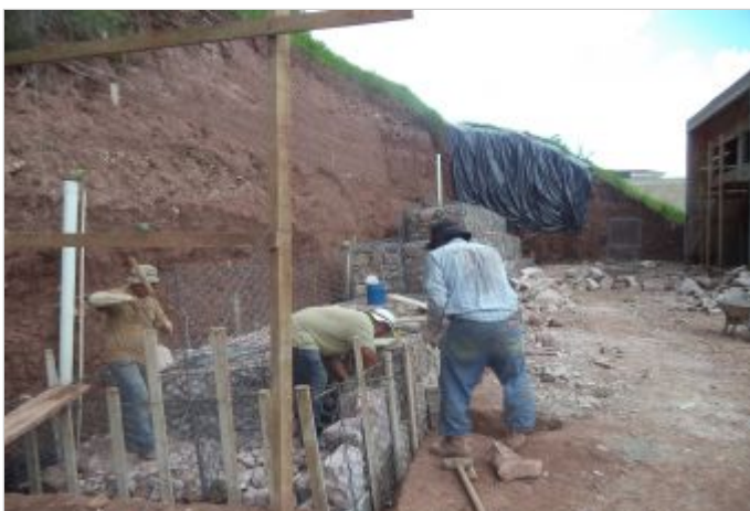
Durante la Obra
