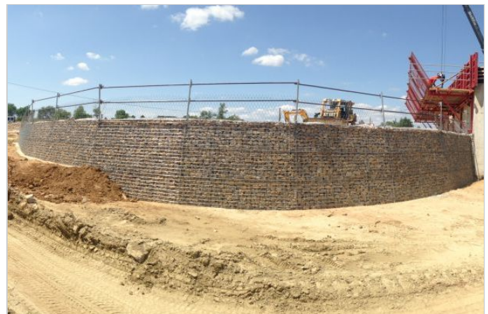
Pendant les travaux
