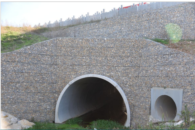
Après les travaux
