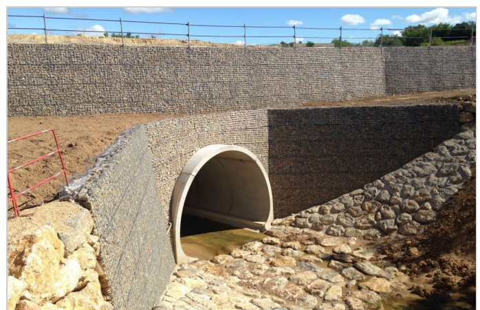
Pendant les travaux
